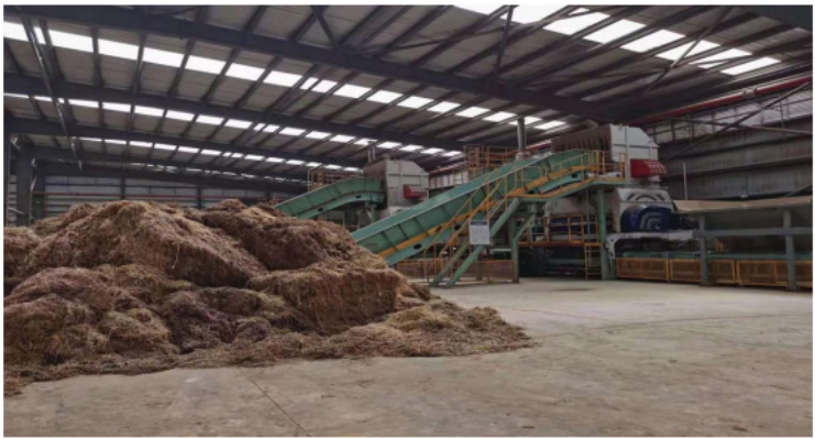
铜陵枞阳海螺水泥有限公司生物质替代燃料项目
