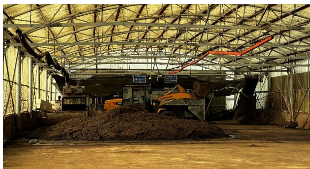
图 12 南昌牧原二场的干粪处理设施
